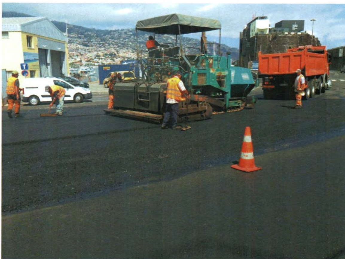
Trabalhos de pavimentação da entrada do porto do Funchal
