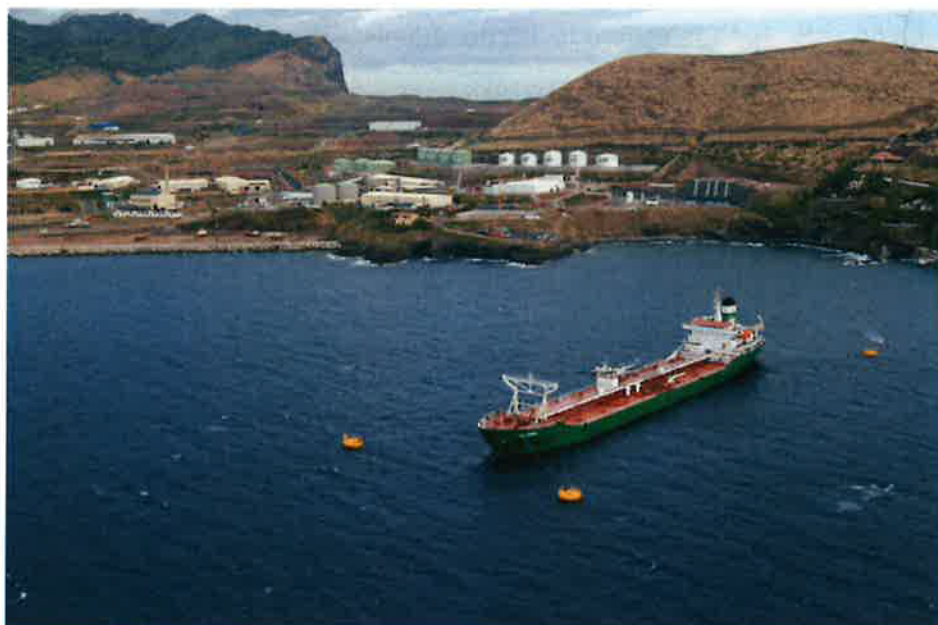
Imagem terminal CLCM Caniçal (imagem site oficial Ordem dos Engenheiros)
