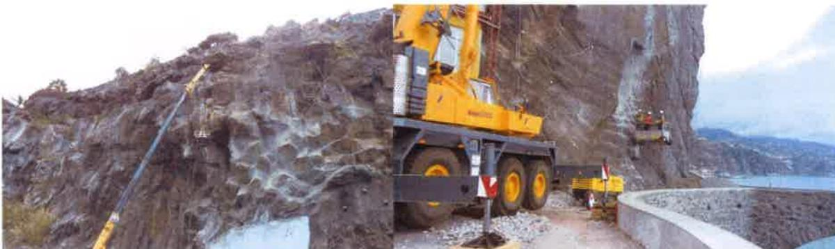
Foto 7– Reabilitação da Proteção de Taludes da Falésia
