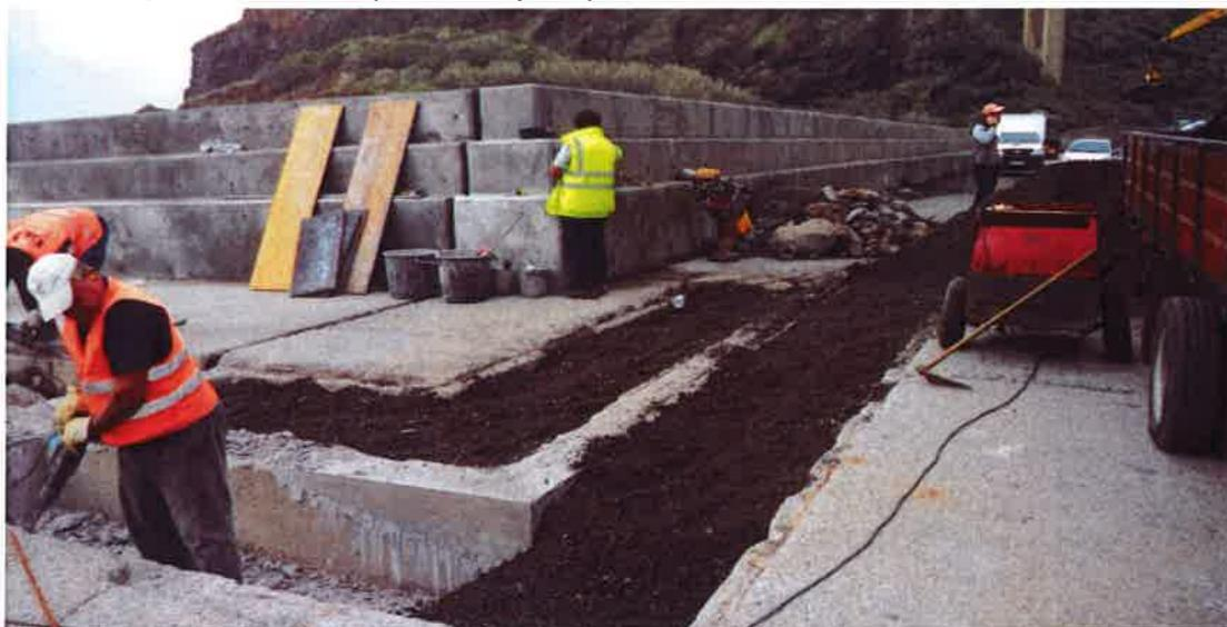
Obras de reparação do muro-cortina, caleira técnica de combustíveis e da aresta da zona de acostagem do cais, no valor de 55.200,01€.
