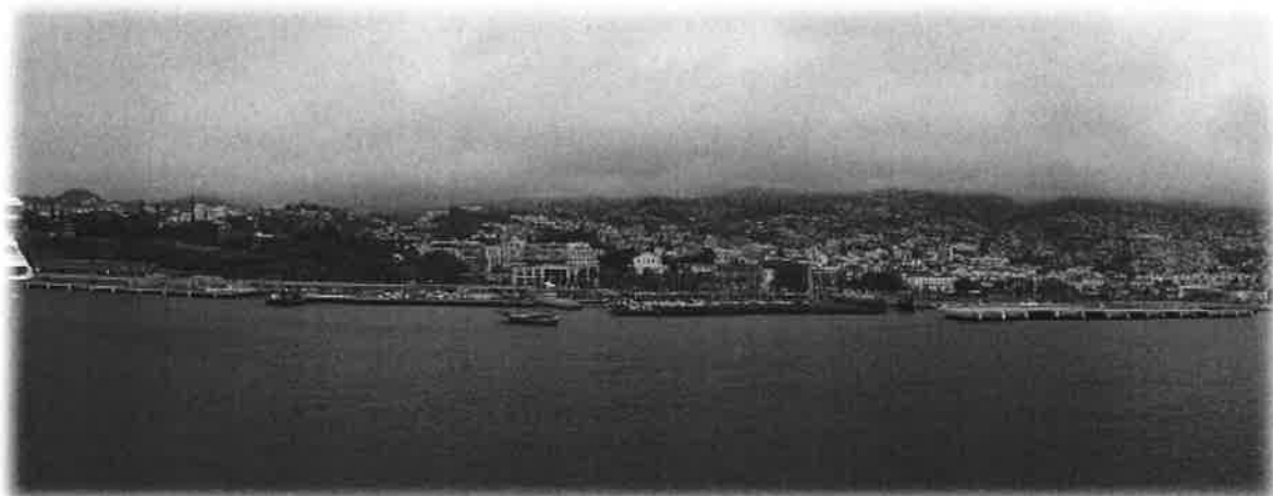
Foto 1 – Vista geral do cais 6 (terminal norte) e cais 8
