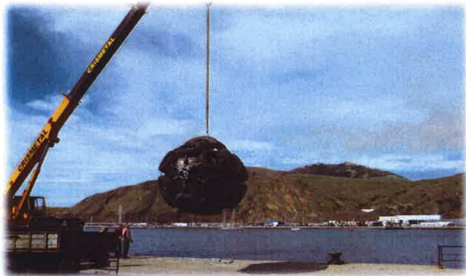
Foto 4 - Defensas do porto do Porto Santo
