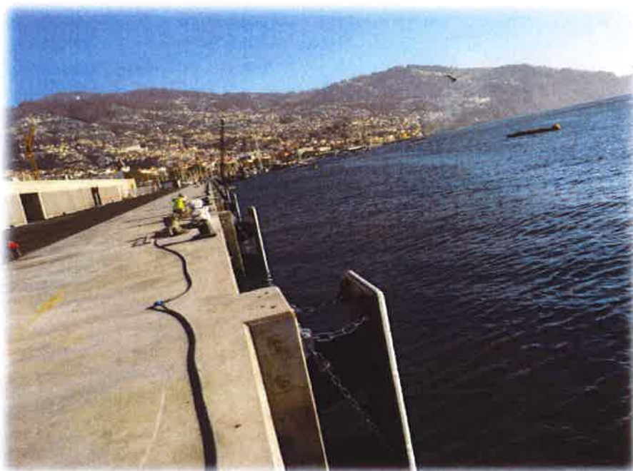
Foto 2– Defensas do cais 6 (terminal norte)
