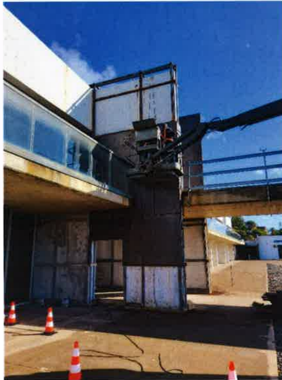
Foto 6 – Remoção das chapas em aço corten
