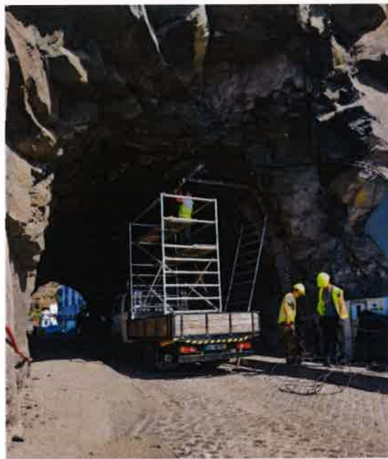
Foto 9 – Túnel da Ribeira Brava
