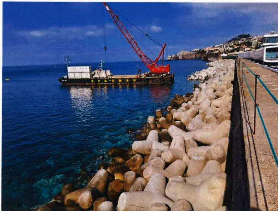
Foto 1- Colocação dos tetrápodes
