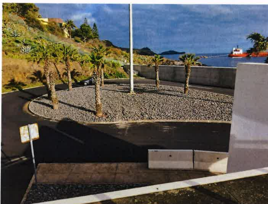
Foto 5 – Pavimento e canteiro reparados
